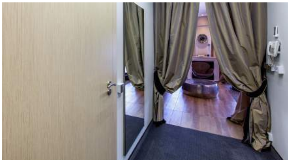
drzwi EI30 PLUS jednoskrzydłowe, ościeżnica stała drewniana
