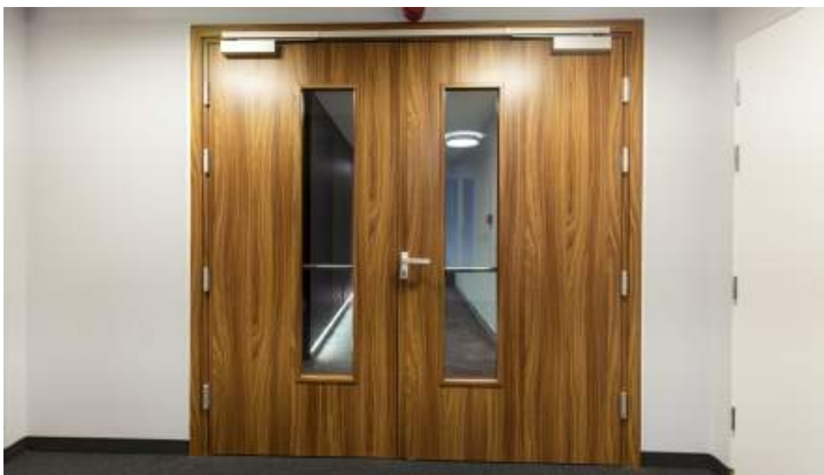
drzwi przeciwpożarowe FR EI30, ościeżnica stała drewniana
