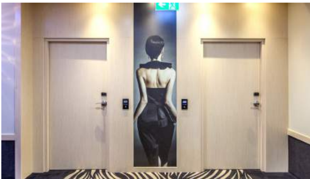
drzwi przeciwpożarowe FR EI30, ościeżnica stała drewniana
