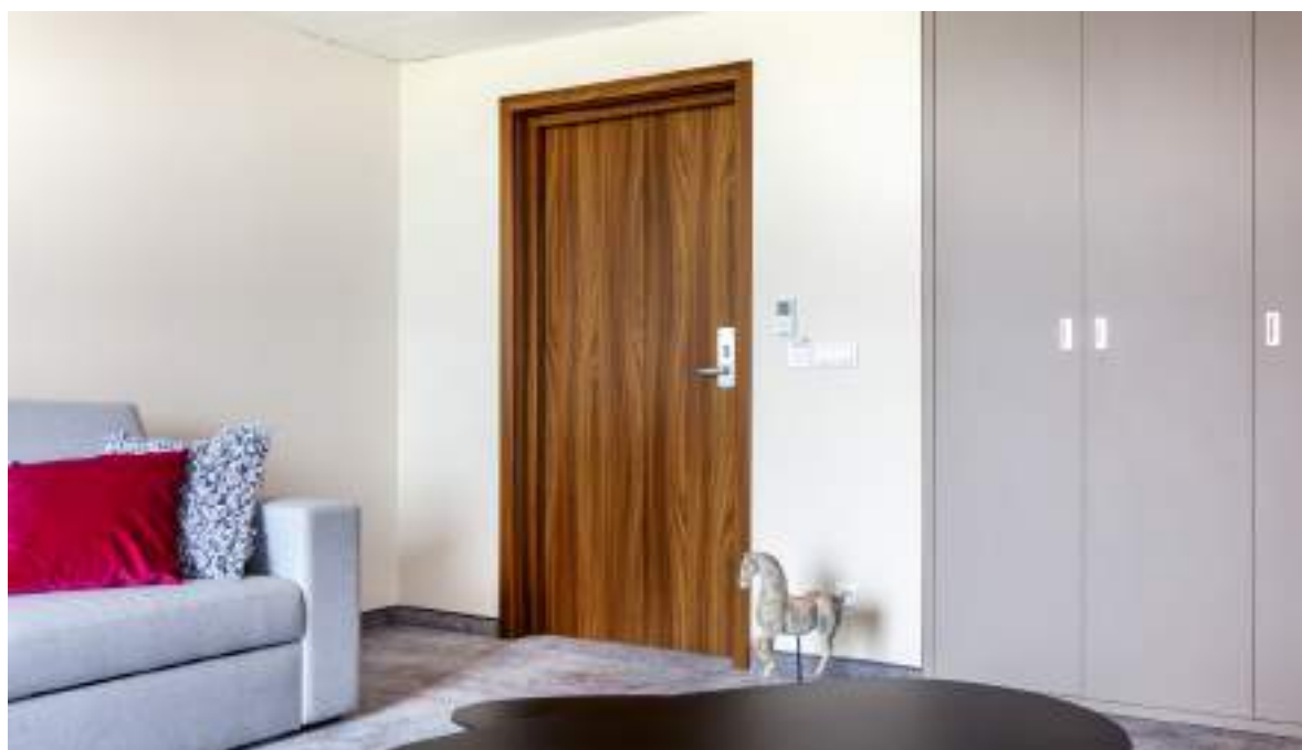
drzwi EI30 PLUS jednoskrzydłowe, ościeżnica regulowana drewniana
