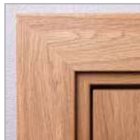
standardowe łączenie opasek pod kątem 45°
